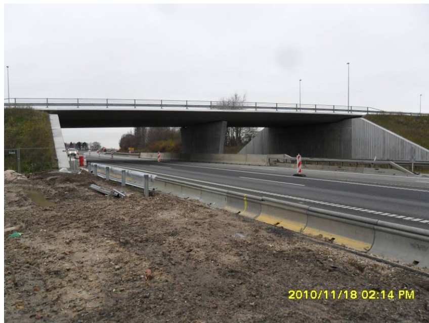
OF af Maglegårdsvej Insitu støbt efterspændt pladebro
