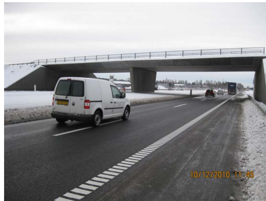
OF af Vesterled Præ-fab løsning
